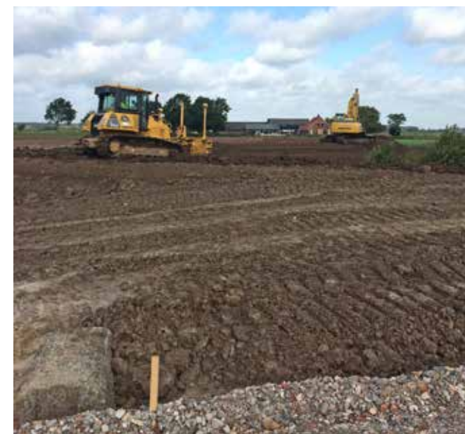
De Slaagse Dijk bij Krachtwijk wordt afgewerkt.
